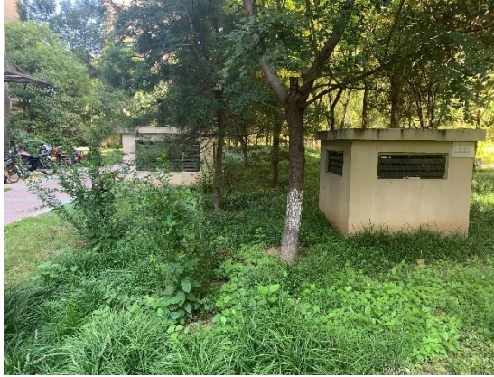
155 地块排风竖井 (1)
