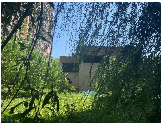
159 地块排风竖井 (5)
